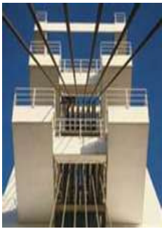
Chevalement de puits de mine avec câbles de hissage.
